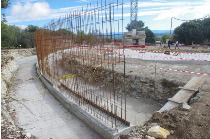
H. Saveuse - Les fondations sont prêtes à accueillir la coupole parabolique.
